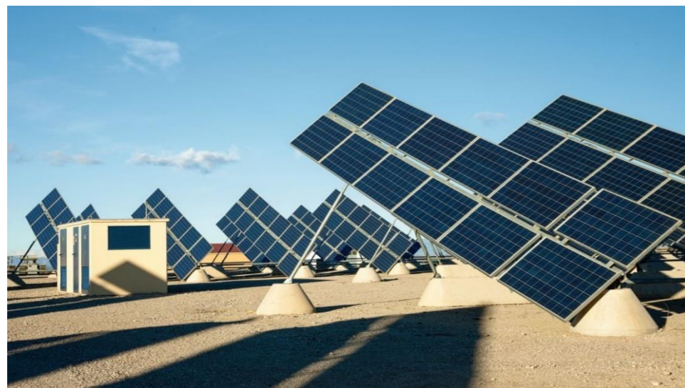
Photo 4 : Suiveurs à rotation bi-axiale (Source : PV Europe)
