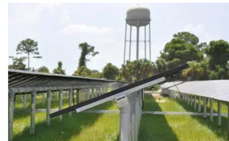
Photo 3 : Suiveurs à rotation mono-axiale (Source : DirectIndustry)
